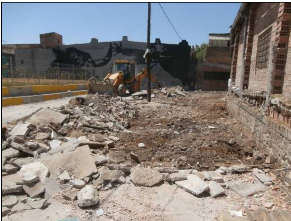
Fotografia 3: El formigó parcialment extret.
