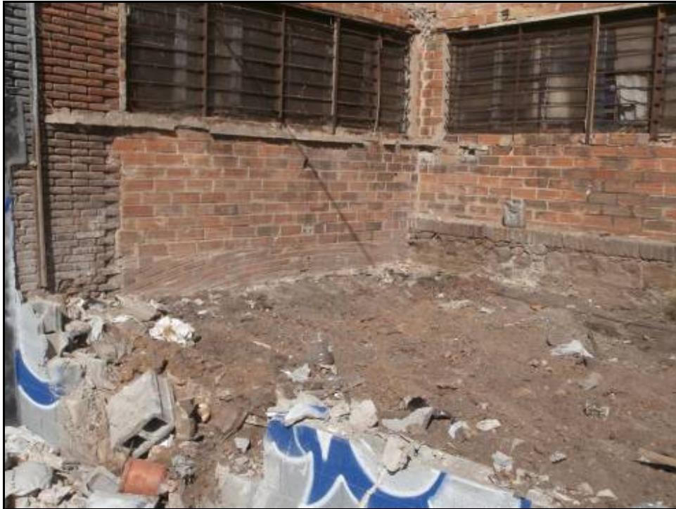
Fotografia 35: Arc de descàrrega recolzant-se en el mur UE 106.
