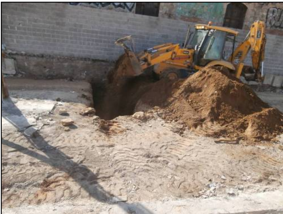
Fotografia 19: Rebliment de les rases amb les mateixes terres extretes.
