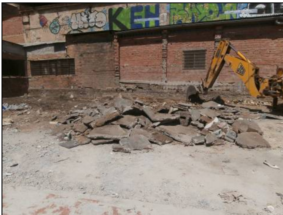
Fotografia 2: Extracció del formigó (UE 100) que sustentava els paviments de les finques enderrocades.
