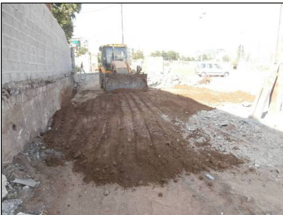
Fotografia 20: Treballs de rebliment finalitzats.
