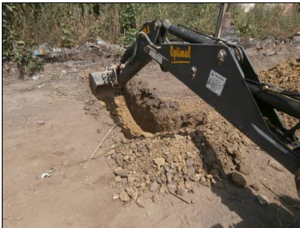
Fotografia 23: Inici d'excavació de la Rasa 4.
