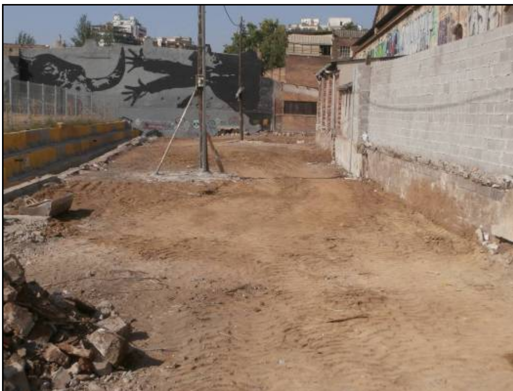
Fotografia 4: Vista general del solar sense el formigó, presa des del carrer del Dos de Maig.
