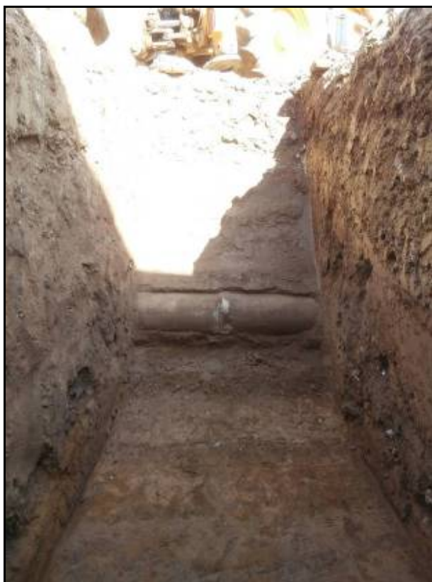
Fotografia 16: Canonada d'aigua a l'extrem sud de la Rasa 3.
