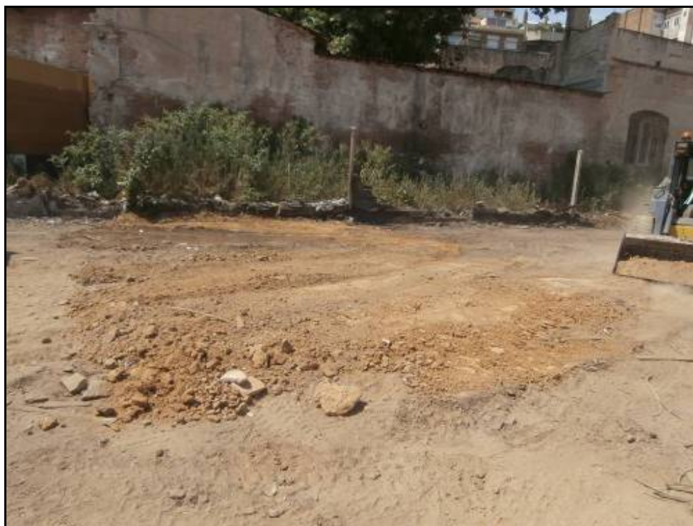
Fotografia 31: Treballs de rebliment finalitzats.
