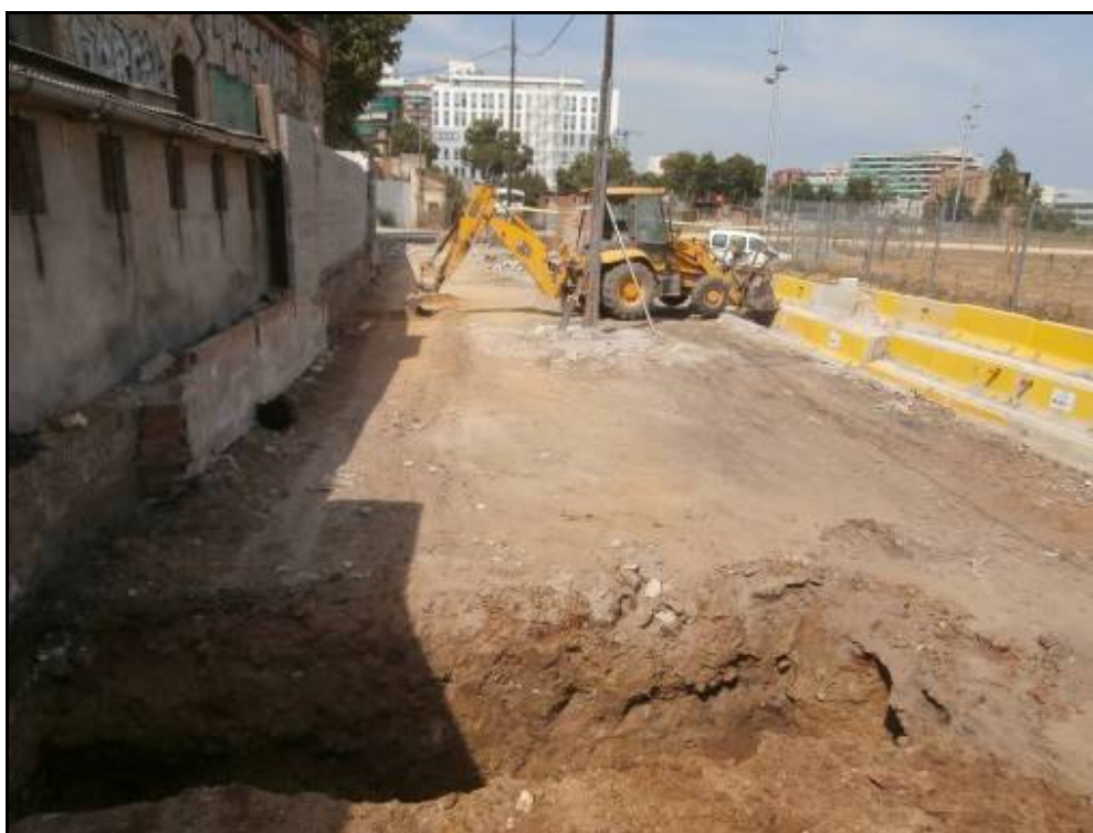
Fotografia 14: Inici de la Rasa 3, a l'extrem est del solar. En primer terme la Rasa 2.
