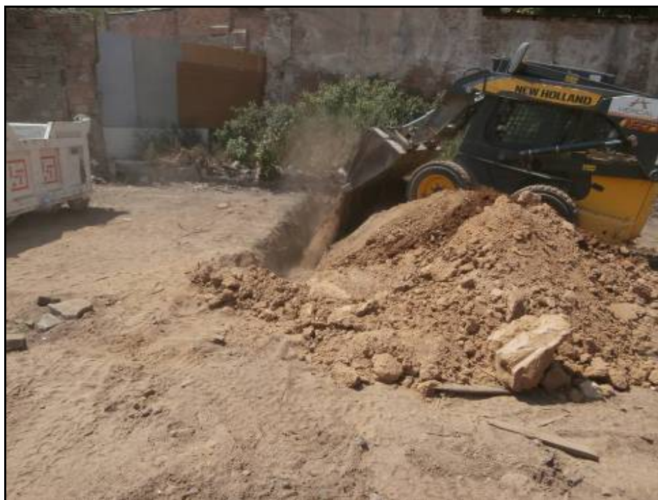
Fotografia 30: Rebliment de les rases amb les mateixes terres extretes.
