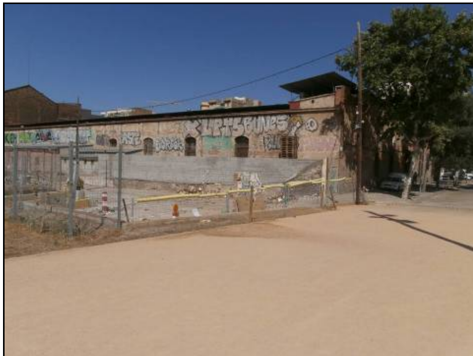
Fotografia 1: Vista general del solar, núm. 187 I, al carrer del Dos de Maig.
