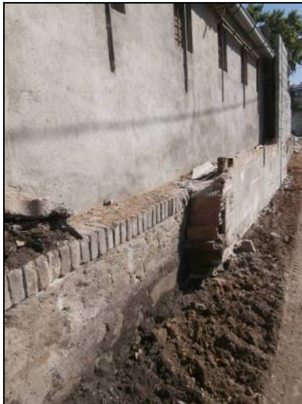
Fotografia 33: Detall de parets recolzant-se en el mur UE 106.
